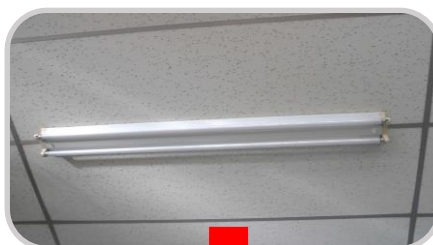
教室照明器具修理
